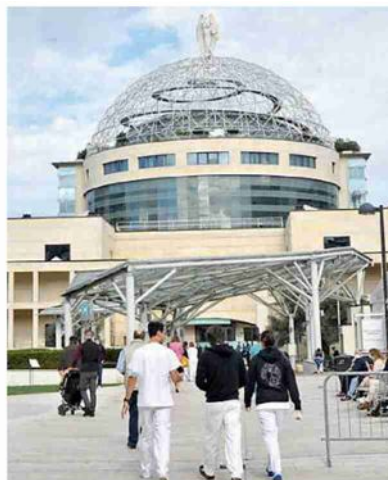
1 L'ingresso al pronto soccorso dell'ospedale San Raffaele Irccs di Milano
