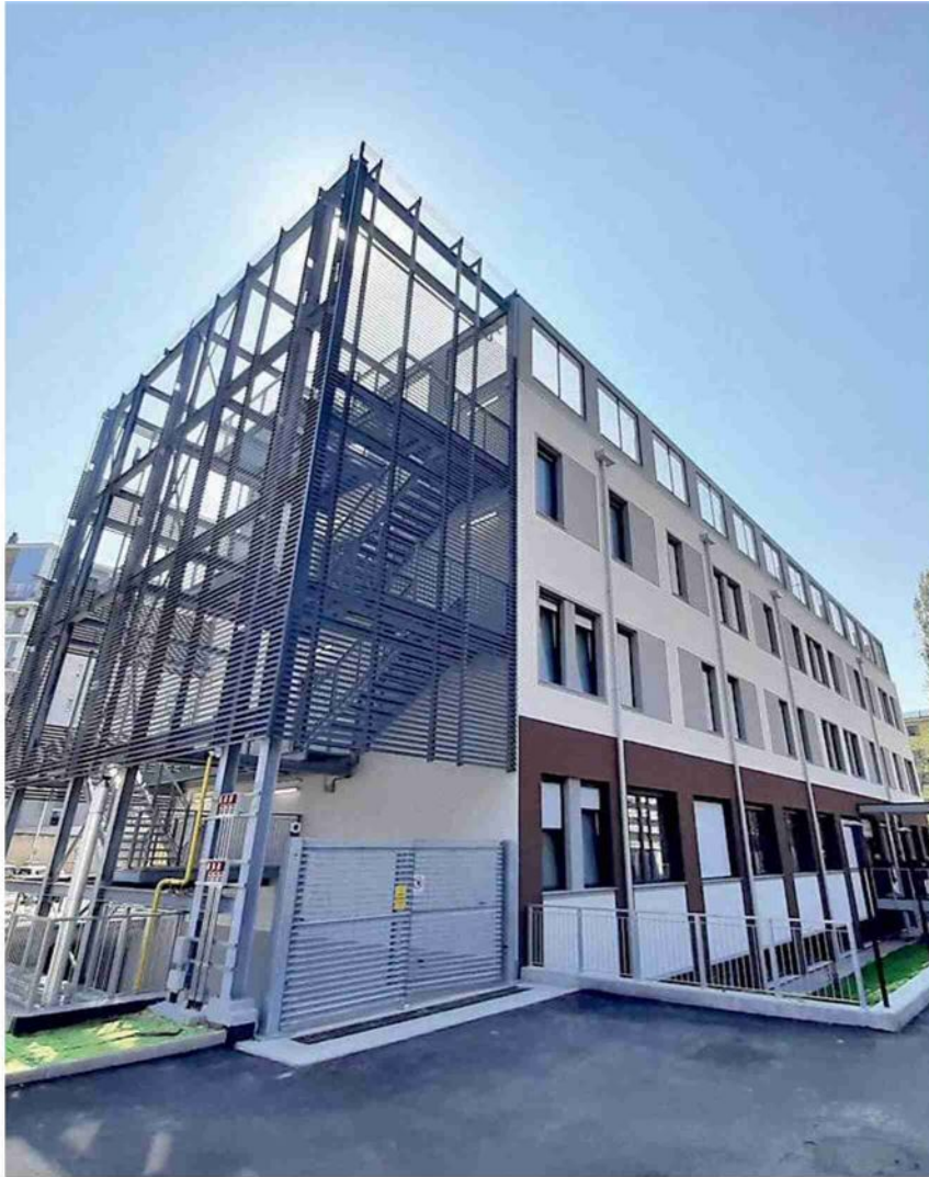
Una delle nuove case di comunità a Torino, in corso Toscana
